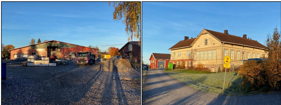
Rakenteilla oleva päiväkoti ja nuorisotalo, entinen kansakoulu.
